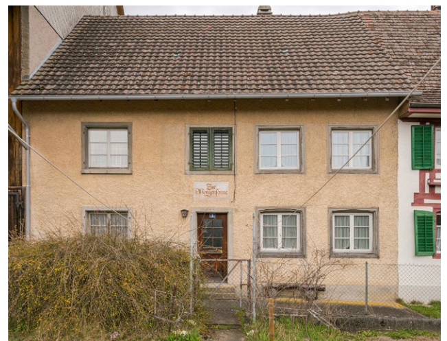
Das Haus zur Morgensonne beendet die lange Reihe der drei Bauernhäuser an der Hinterdorfstrasse.
