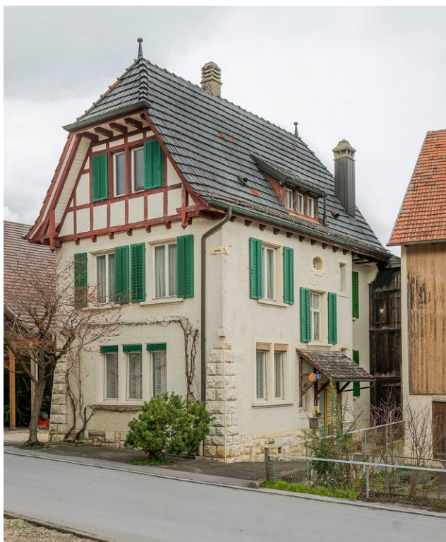
Das alte Zollhaus an der Schlatterstrasse 6.
