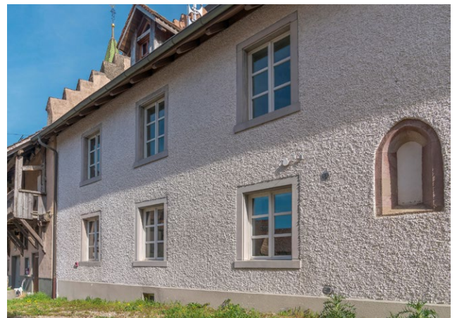
Die Nordfassade der ehemaligen Jakobskapelle mit der Sandsteineinfassung eines gotischen Fensters.
