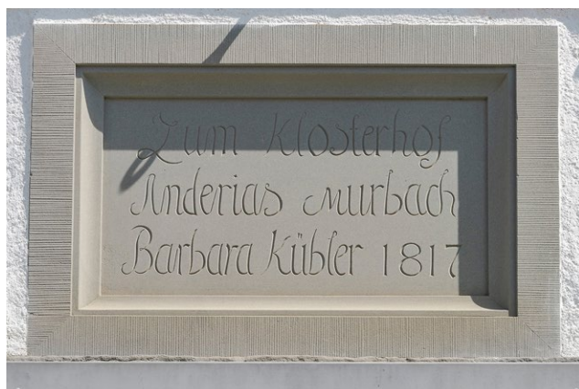
Die markante Hausinschrift über dem Eingang.
