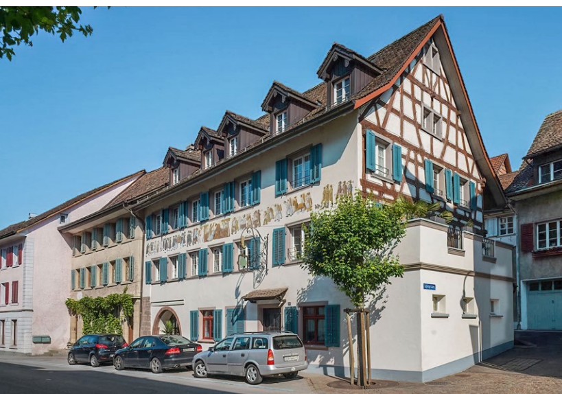
Das ehemalige Gasthaus zur Linde an der Hauptstrasse 27 wird bereits 1679 erwähnt.
