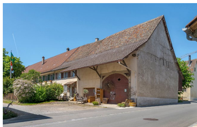
Gebäudezeile Rössligasse 25+27, Südansicht.
