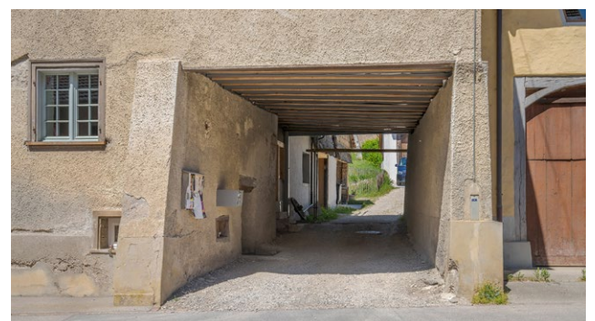
Der östliche renovierte Hausteil des Gasthauses zum Engel mit Durchfahrt für Fuhrwerke.
