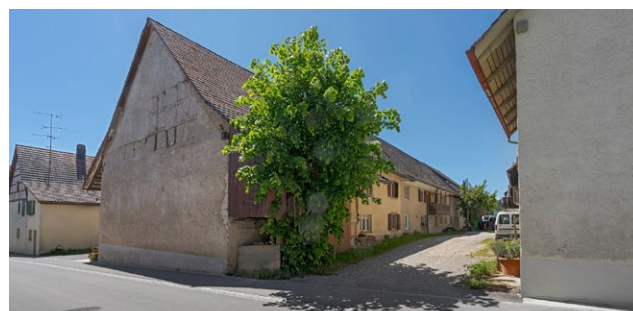
Gebäudezeile Rössligasse 25+27, Nordseite.
