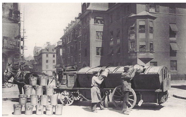
Das System Ochsner ist in Zürich ab 1896 im Einsatz.
