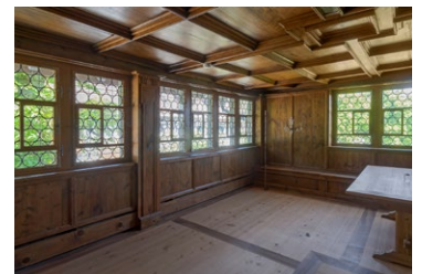
Historisches Raumgefühl mit Felderdecke und Wandtäferung.
