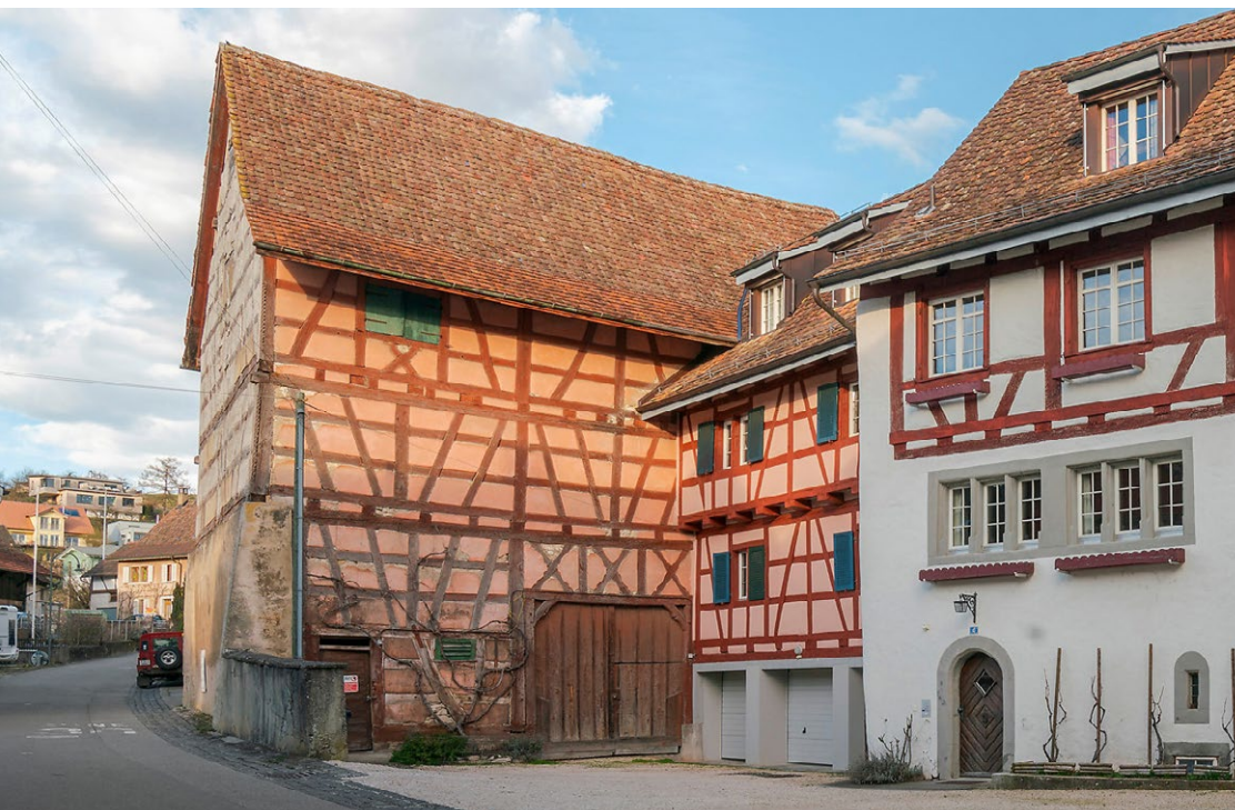
Die Zehntenscheune mit seinem markanten Fachwerk.
