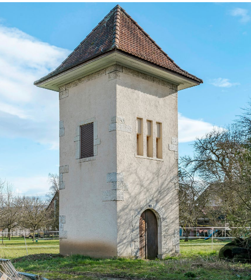
Ausgänge für ehemaliges Freileitungsnetz.
