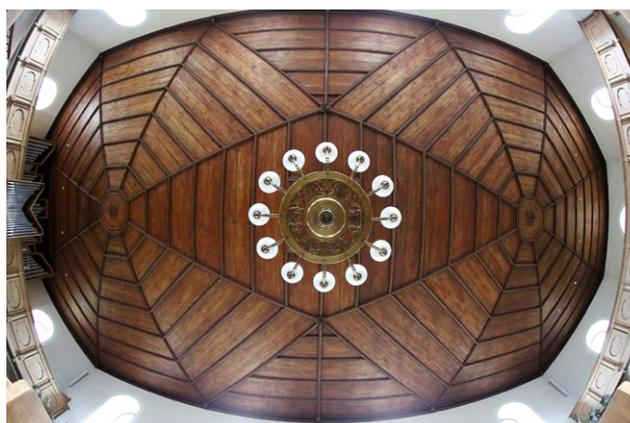
*Die hängende Deckenkonstruktion benötigt keinerlei Säulen.
